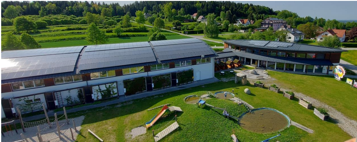
Figure 45: Exterior view of Sonnenplatz Großschönau
